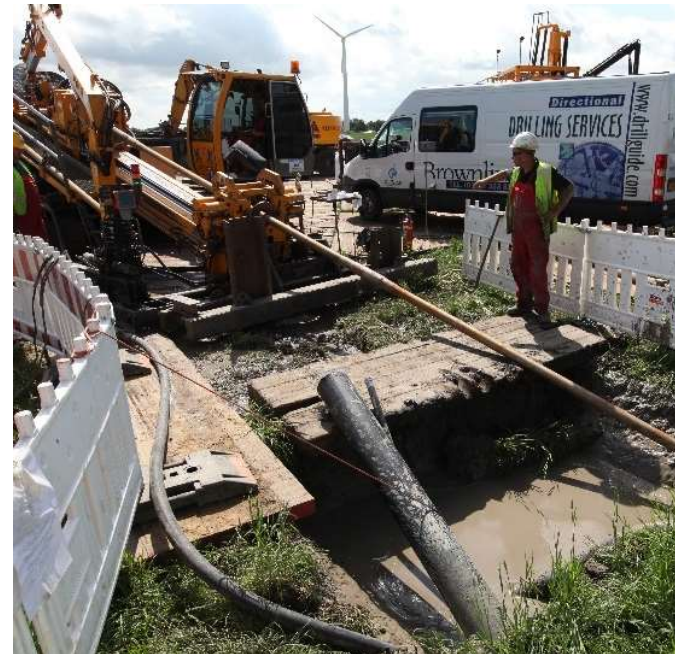
Geschlossene Verlegeweise (z.B. Horizontalspülbohrung; Microtunnel; E-Powerpipe)
